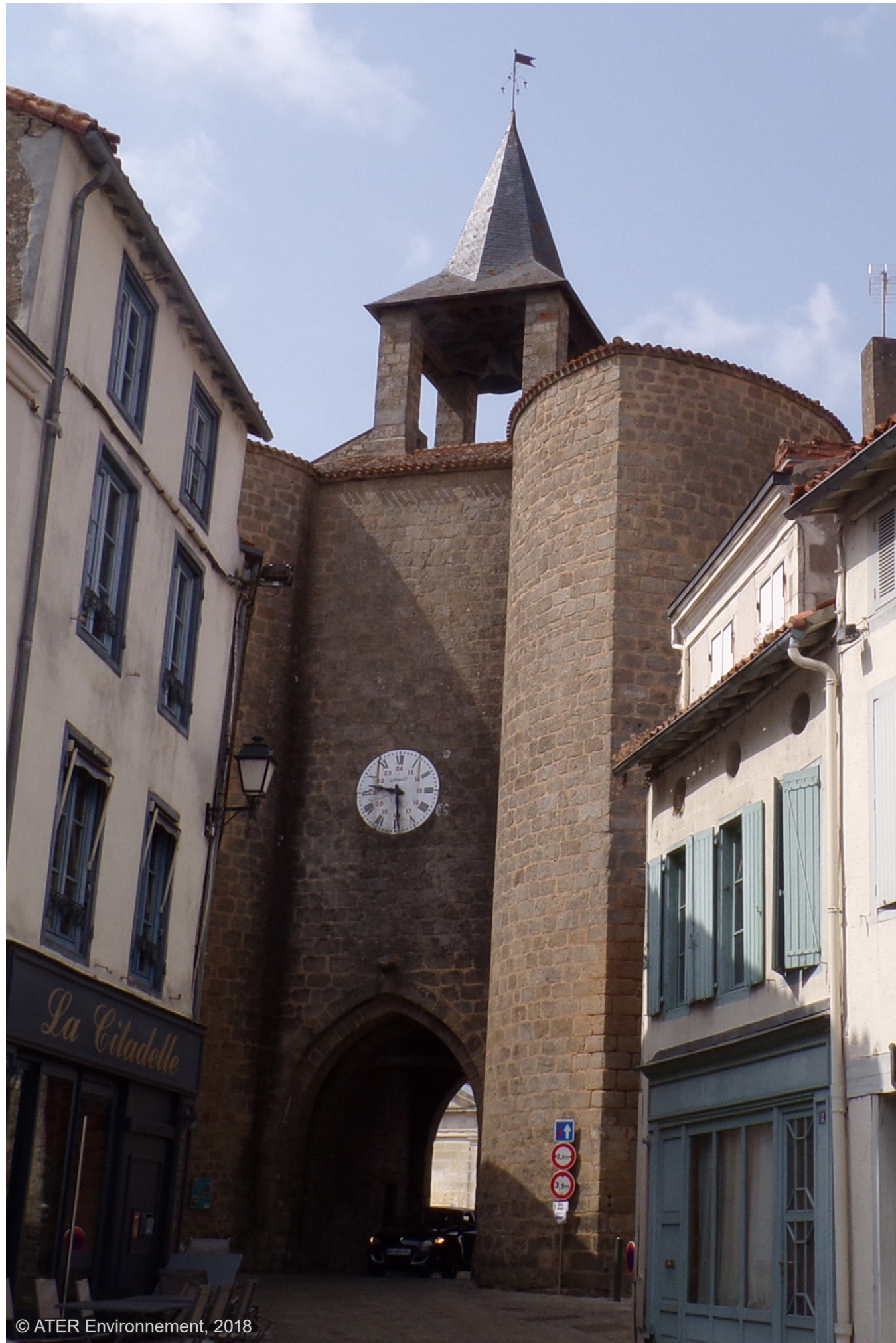
Fig. 63 : Clocher implanté au niveau des remparts - PARTHENAY
